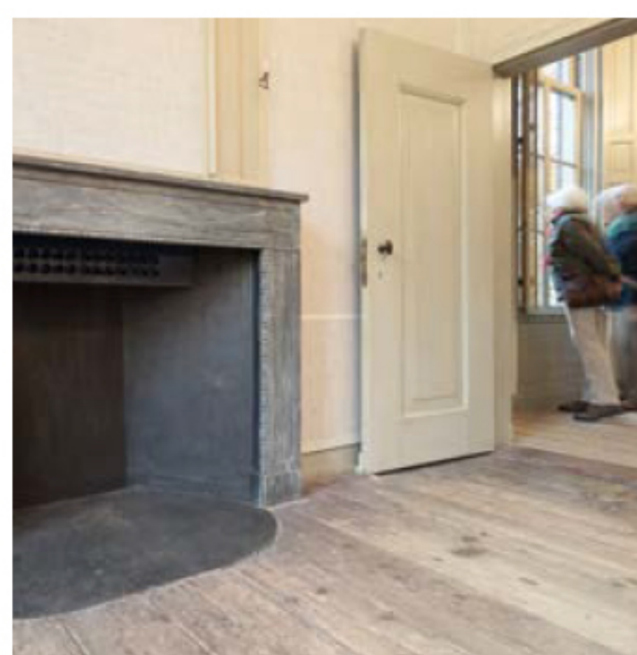
Voor een nieuwe klimaatinstallatie is handig gebruikgemaakt van de schoorsteenkanalen
