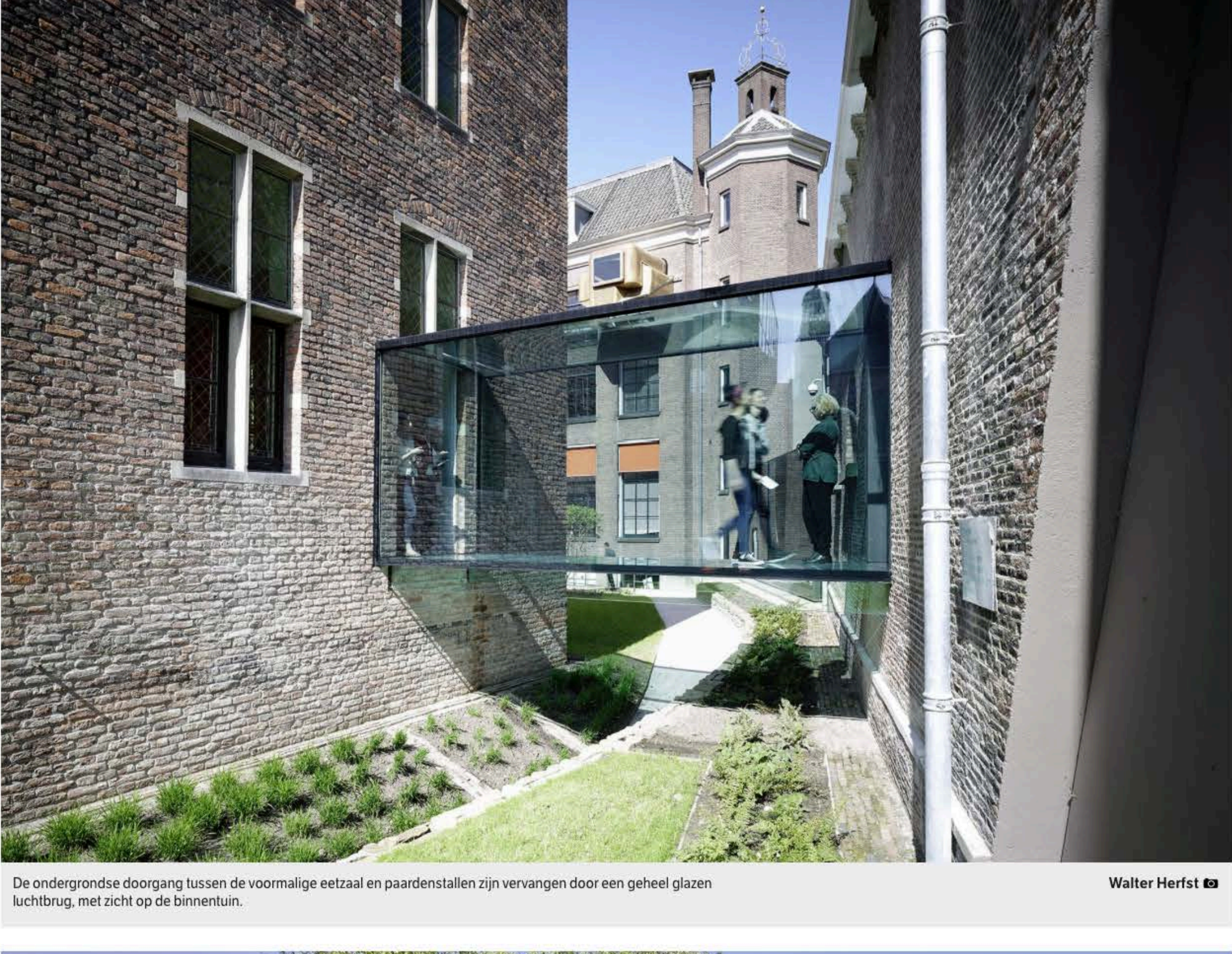
De ondergrondse doorgang tussen de voormalige eetzaal en paardenstallen zijn vervangen door een geheel glazen luchtbrug, met zicht op de binnentuin. Walter Herfst
